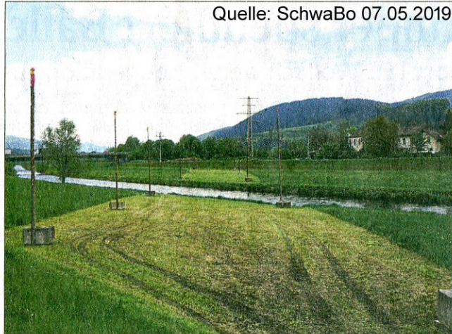
Die gemähte Wiese soll die Breite der Brücke darstellen, das Konstrukt mit Seilen ihre Höhe. Foto: Kleinberger
